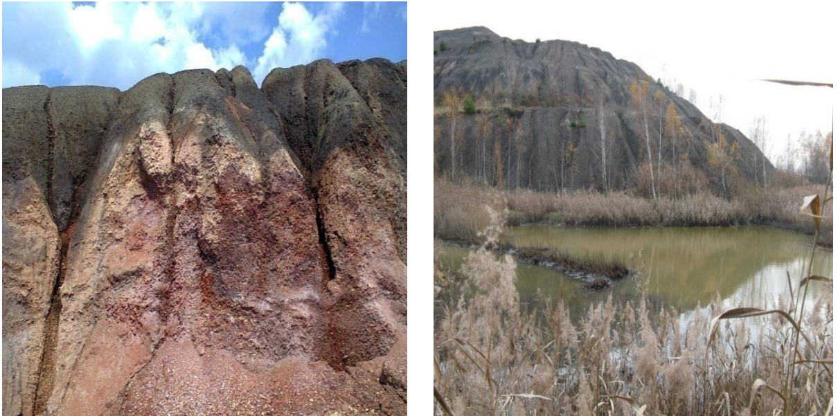
Рис. 2.1.3. Ерозійні процеси на відвалі ЦЗФ “Червоноградська”.
